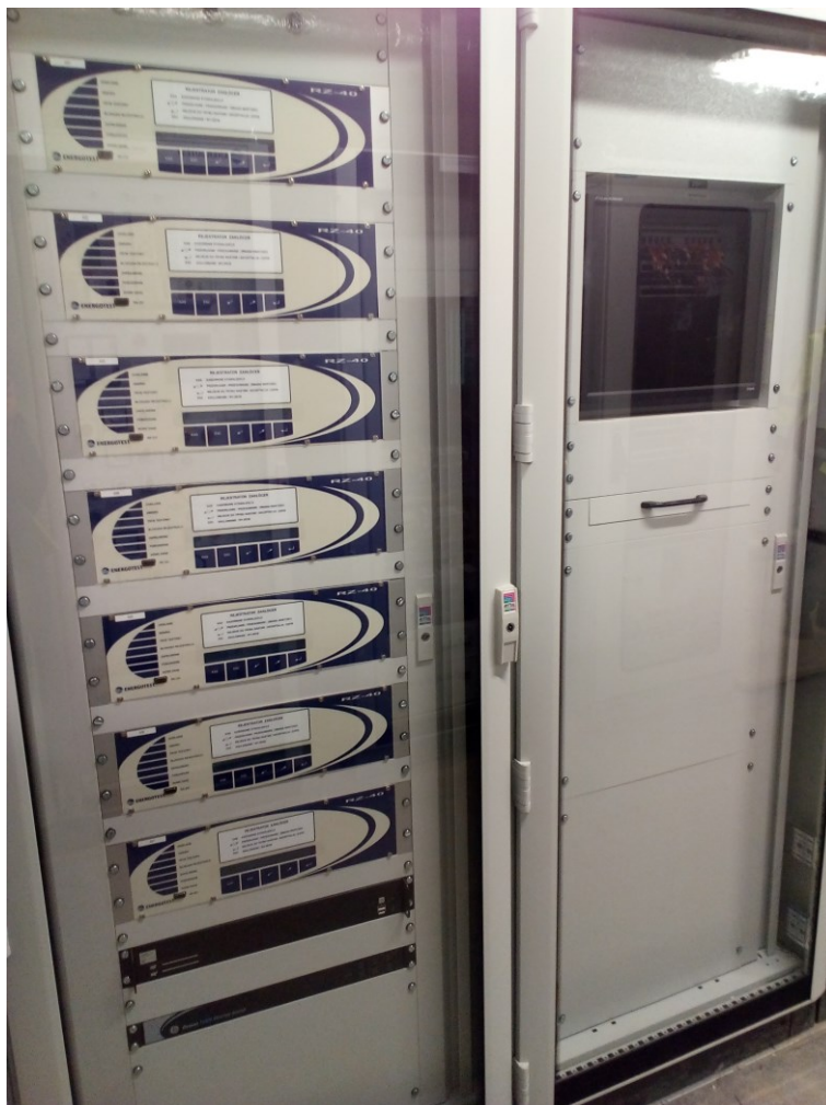
Zdjęcie 4. Po Lewej stronie widok na elewacje szafy rejestratorów, z prawej strony widok na elewację szafy stacji inżynierskiej zabezpieczeń i układu zewnętrznej rejestracji zakłóceń.
