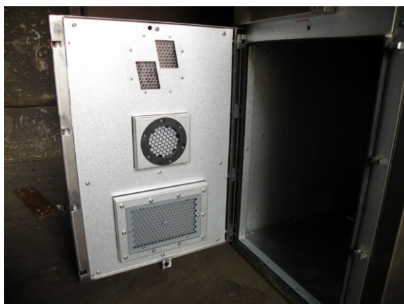
Fot. 1. Drzwi przedziału przyłączowego z dwoma „okienkami termowizyjnymi”
