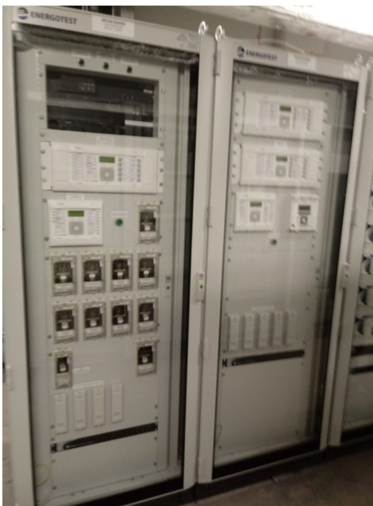
Zdjęcie 1. Szafy zabezpieczeń systemu A - widok na aparaty zabudowane na ramach wychylnych: terminale zabezpieczeniowe, szybkie przekaźniki wyłączające, gniazda testowe
