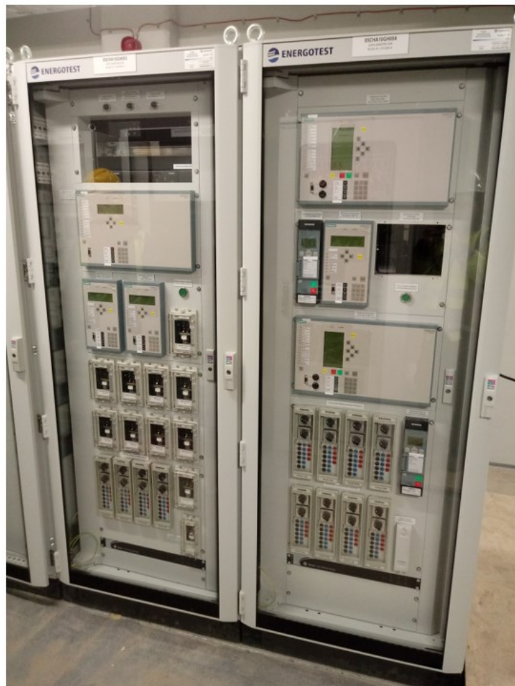
Zdjęcie 2. Szafy zabezpieczeń systemu B - widok na aparaty zabudowane na ramach wychylnych: terminale zabezpieczeniowe, szybkie przekaźniki wyłączające, gniazda testowe
