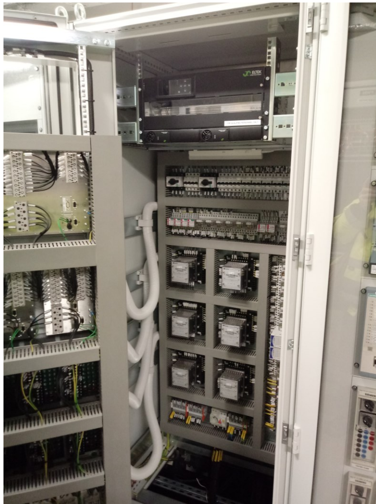
Zdjęcie 3. Szafa zabezpieczeń po otwarciu ramy wychylnej - widok na zasilacz modułowy, obwody dystrybucji napięć pomocniczych i przekaźniki kontroli zaniku napięcia zasilania
